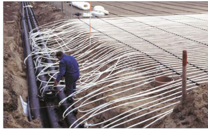
Устройство дренажа на игровом поле
