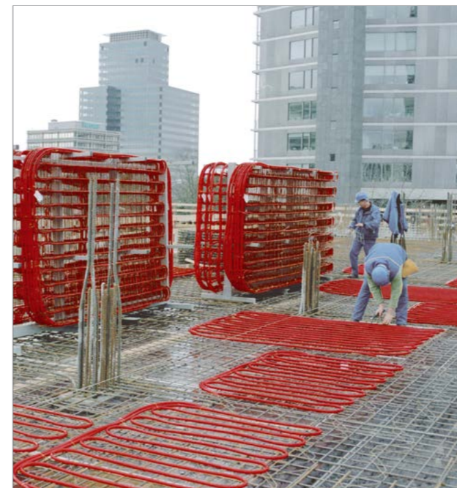
Темперирование ядра бетонных перекрытий
