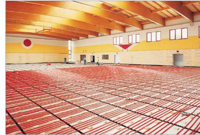
Система отопления вибропола REHAU SBH со стандартным распределительным коллектором
