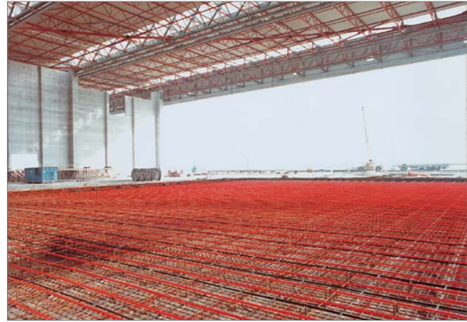
Поверхностное отопление промышленного цеха
