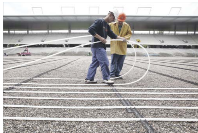
Укладка труб для обогрева
