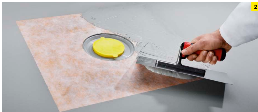
Нанесение второго слоя уплотнения с проверенной на практике двухкомпонентной обмазочной гидроизоляцией.
